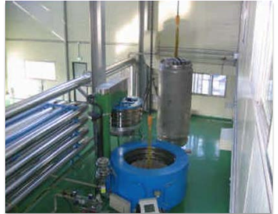
Detalle de la carga de un extractor
