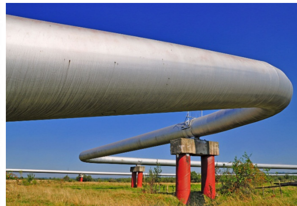
Transporte por tubería
