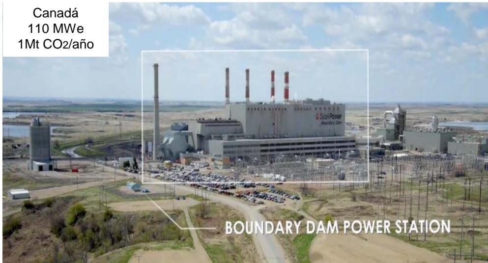
Primera planta comercial de captura de CO<sub>2</sub> en una central térmica de carbón
